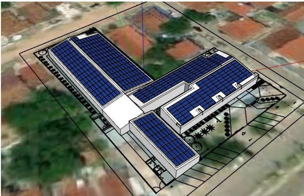
O sistema dimensionado para o Hospital está composto por 440 módulos de 400W totalizando 176 kWp. Os módulos estarão interligados formando arranjos de 22 módulos em série. Os módulos serão interligados em 3 inversores, totalizando 122 kW. Com esta configuração espera-se atingir uma geração anual de 260,5 MWh, suficiente para suprir o consumo do Hospital e quase 50% dos postos de saúde listados na Tabela 5.
