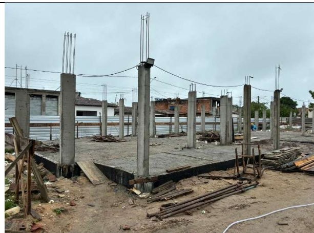
FOTO 16: Lastro de concreto executado;
