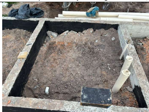
FOTO 12: Pontos de esgoto executados;
