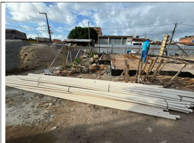
FOTO 13: Tubos de PVC a serem instalados;
