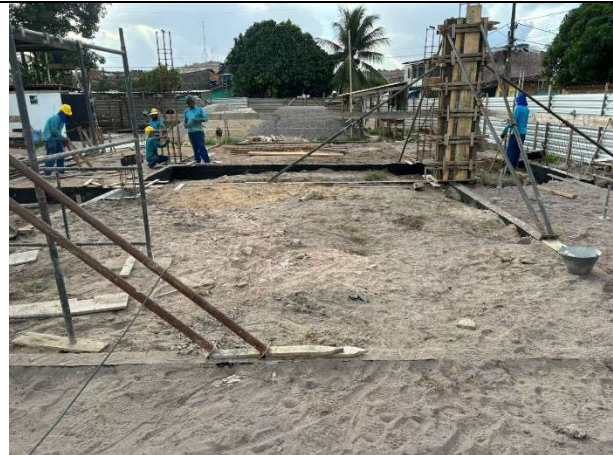
FOTO 18: Concretagem dos pilares;
