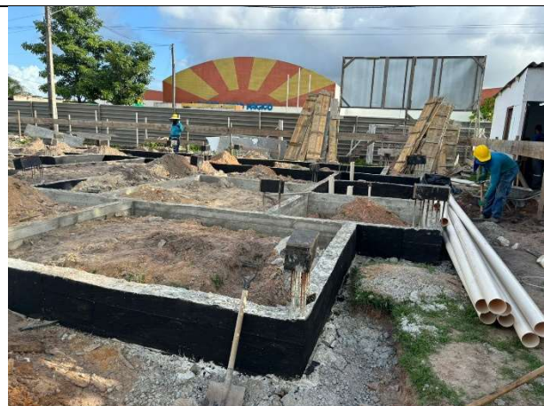
FOTO 14: Impermeabilização das vigas baldrames;
