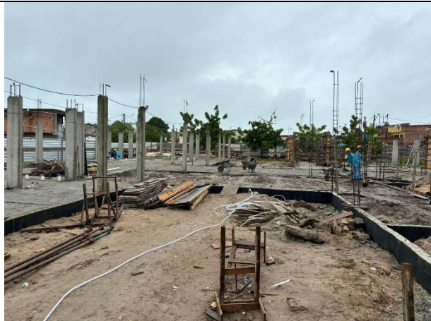
FOTO 17: Lastro de concreto executado;
