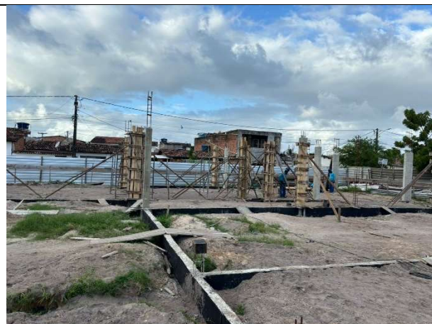
FOTO 8: Impermeabilização das vigas baldrames;
