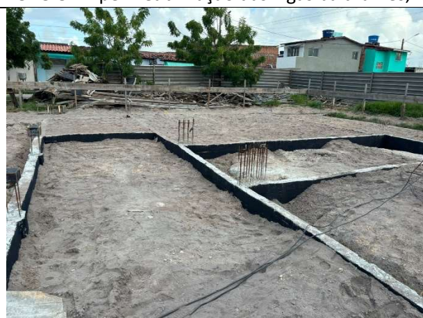
FOTO 10: Impermeabilização das vigas baldrames;
