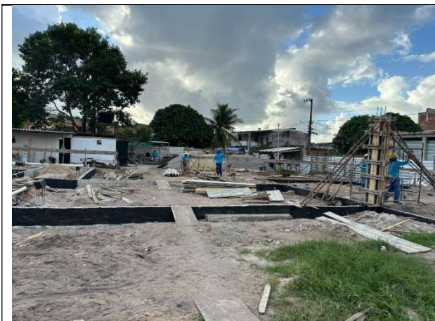
FOTO 7: Impermeabilização das vigas baldrames;
