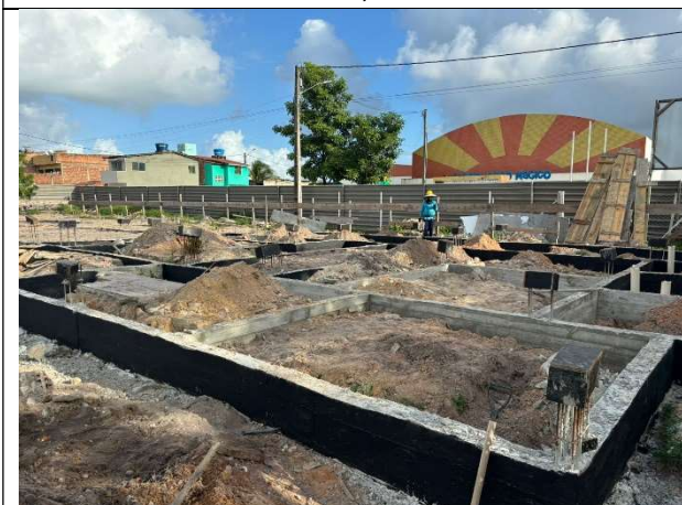
FOTO 11: Impermeabilização das vigas baldrames;
