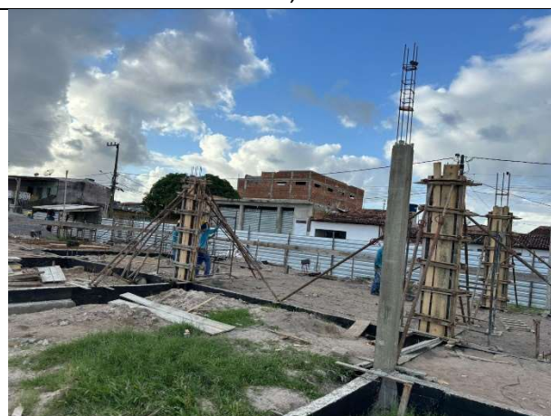
FOTO 6: Concretagem dos pilares;
