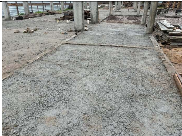
FOTO 15: Lastro de concreto executado;
