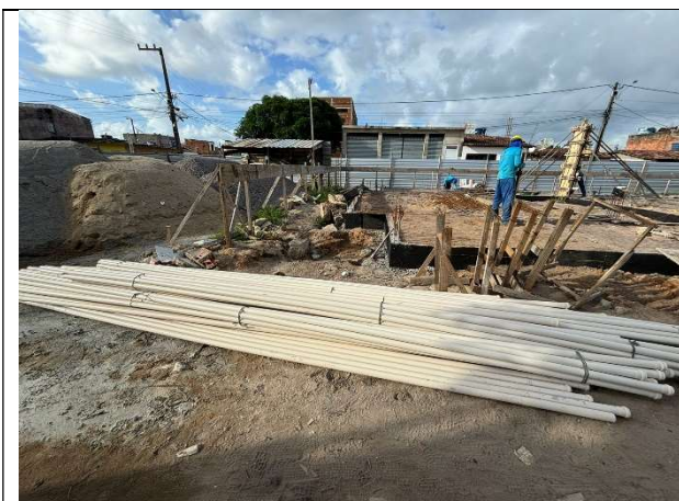
FOTO 13: Tubos de PVC a serem instalados;
