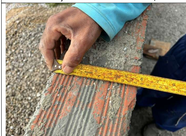
FOTO 11: Alvenaria 1 vez executada;
