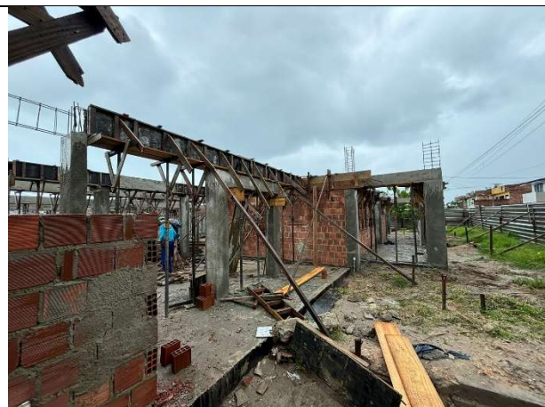
FOTO 2: Alvenaria 1 vez executada;
