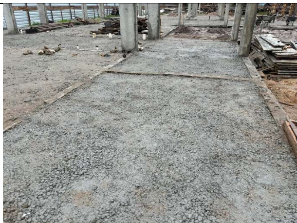
FOTO 15: Lastro de concreto executado;
