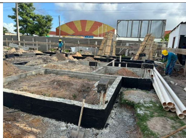
FOTO 14: Impermeabilização das vigas baldrame;
