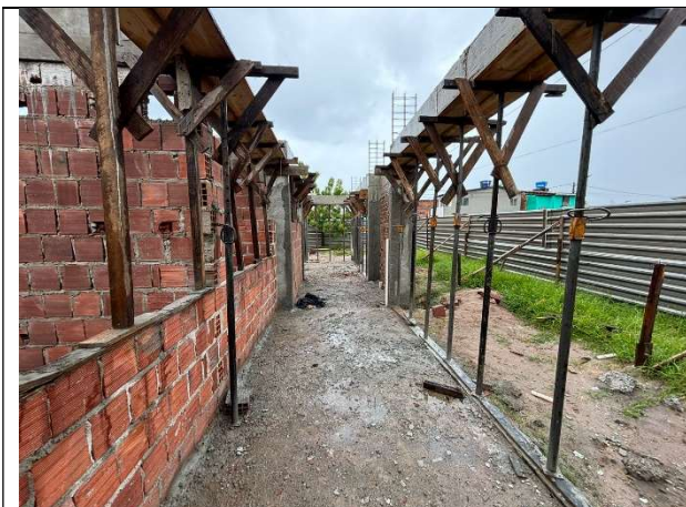
FOTO 1: Alvenaria 1 vez executada;
