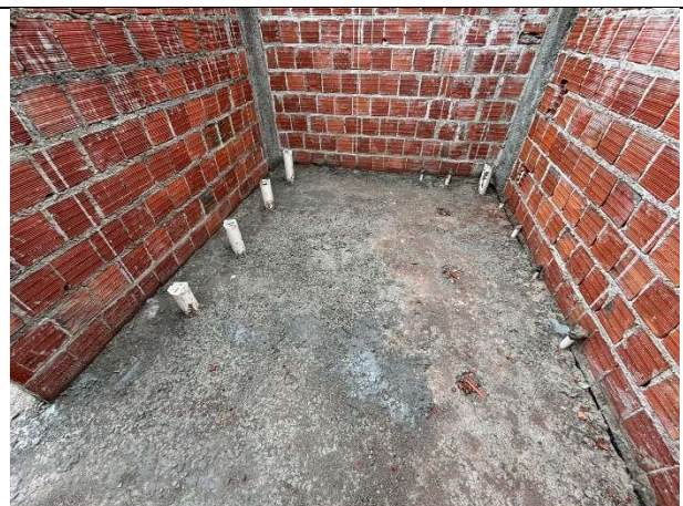
FOTO 8: Instalações sanitárias executadas;
