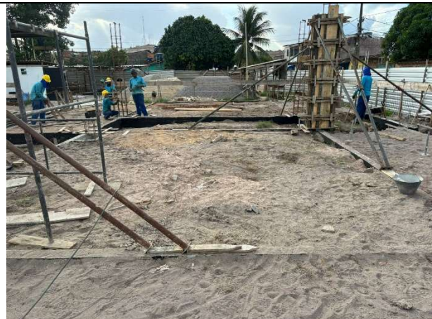
FOTO 18: Concretagem dos pilares;
