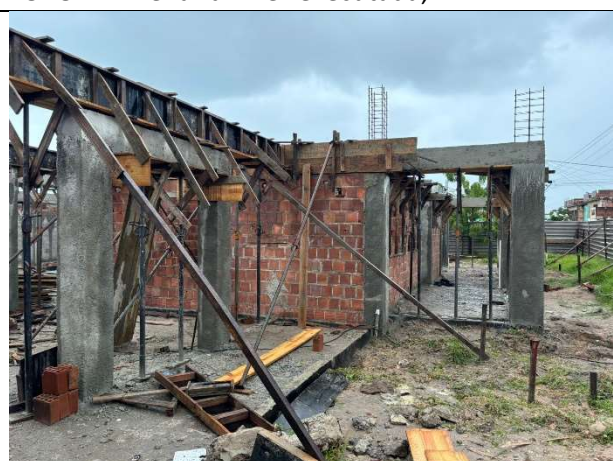
FOTO 4: Alvenaria 1 vez executada;
