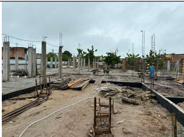
FOTO 17: Lastro de concreto executado;
