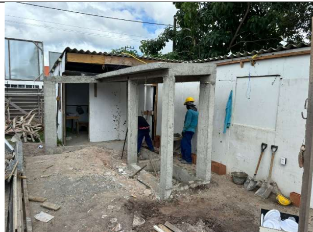
FOTO 2: Abrigo de gás executado;
