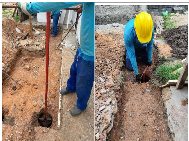
FOTO 3: Escavação da fundação do abrigo de gás;
