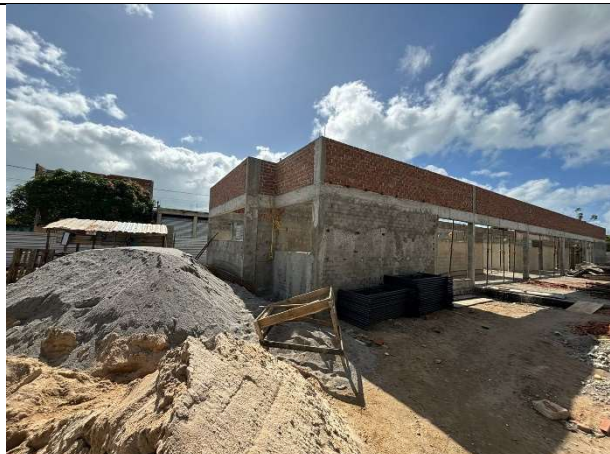
FOTO 1: Platibanda executada;
