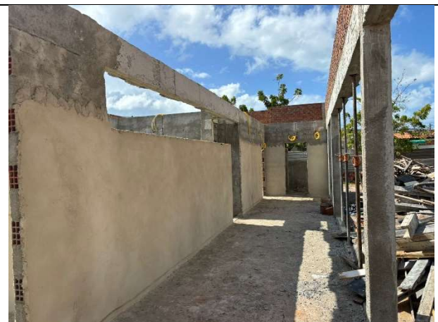
FOTO 8: Reboco executado;
