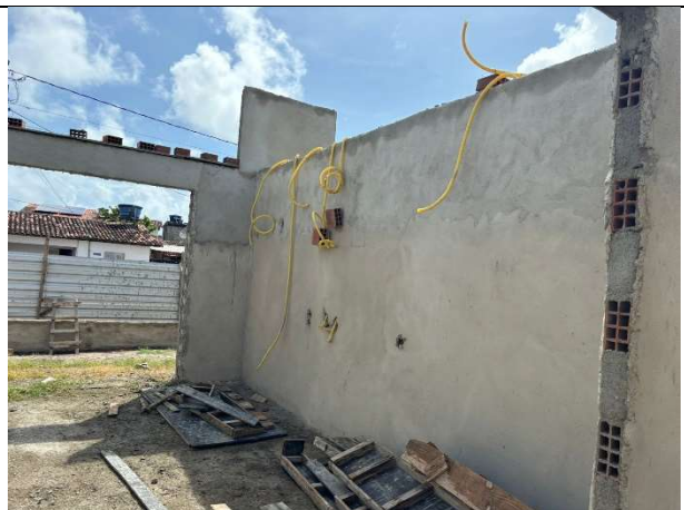
FOTO 6: Reboco executado;
