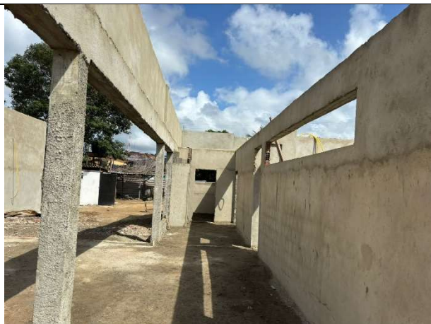
FOTO 5: Reboco executado;
