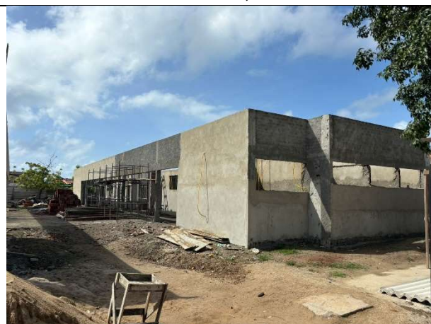
FOTO 12: Reboco executado;
