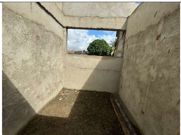
FOTO 4: Reboco executado;
