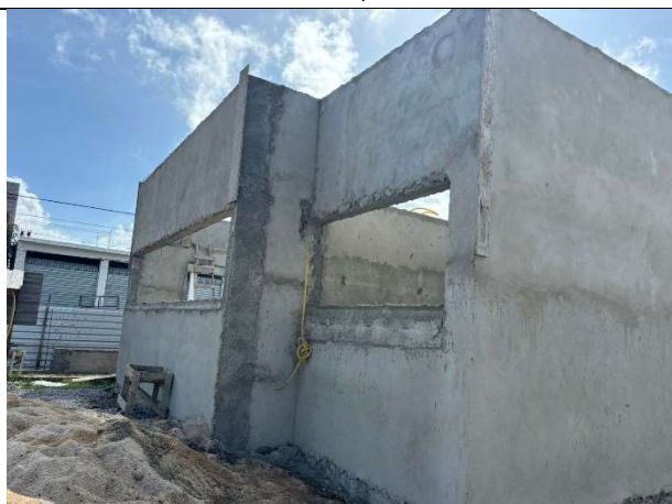
FOTO 11: Reboco executado;
