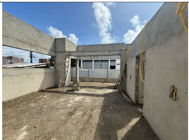
FOTO 2: Reboco executado;
