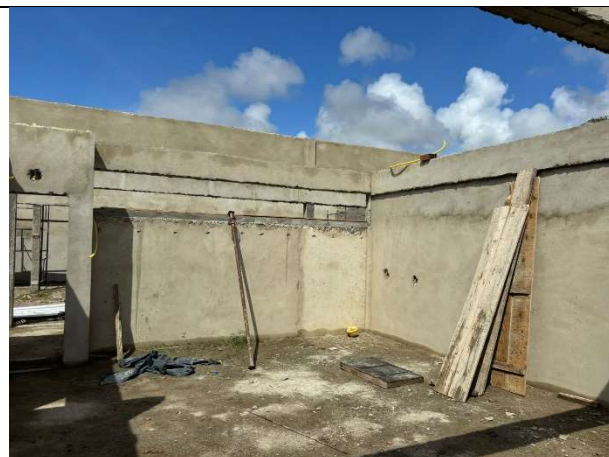
FOTO 8: Reboco executado;
