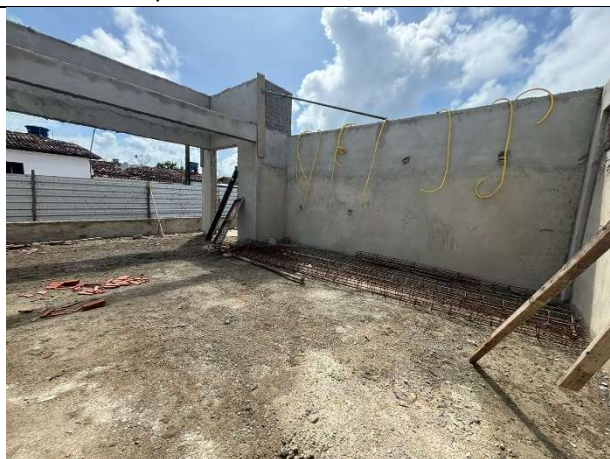
FOTO 3: Reboco executado;
