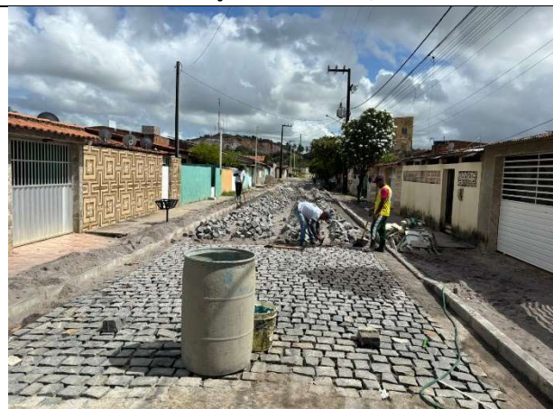
FOTO 4: Pavimentação em execução;
