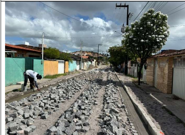
FOTO 5: Pavimentação em execução;
