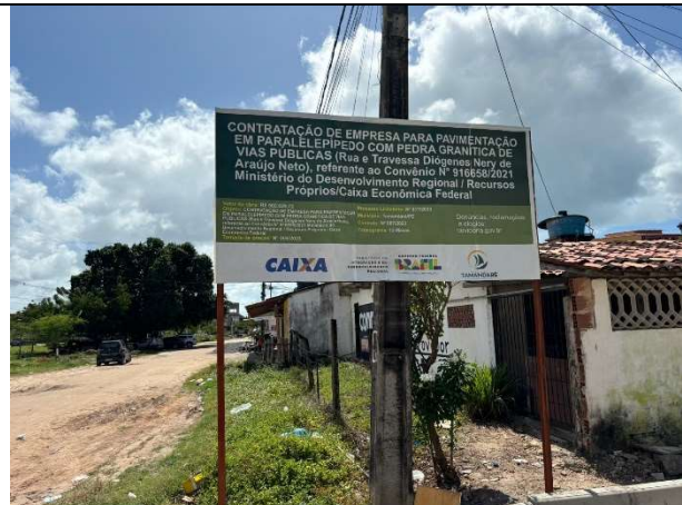
FOTO 6: Placa de obra instalada;
