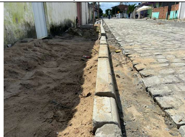
FOTO 6: Sarjeta em execução;
