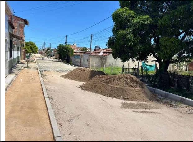
FOTO 9: Pavimentação em execução;
