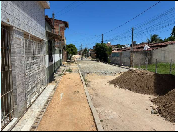
FOTO 10: Pavimentação em execução;
