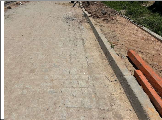
FOTO 7: Sarjeta executada;
