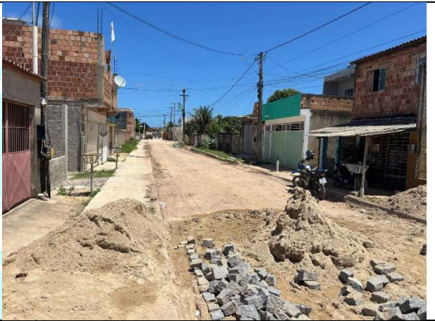
FOTO 8: Pavimentação em execução;
