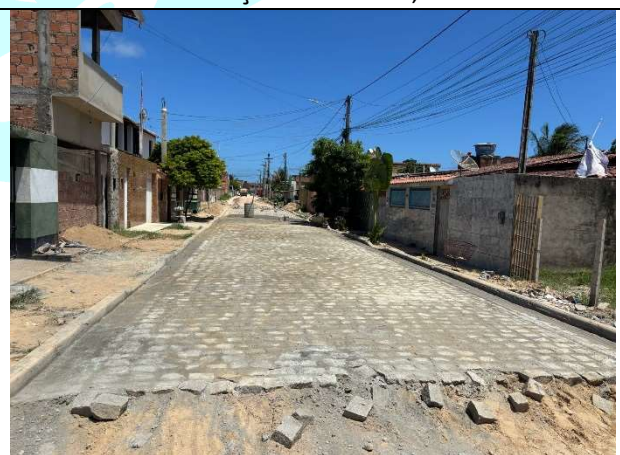
FOTO 6: Pavimentação em execução;
