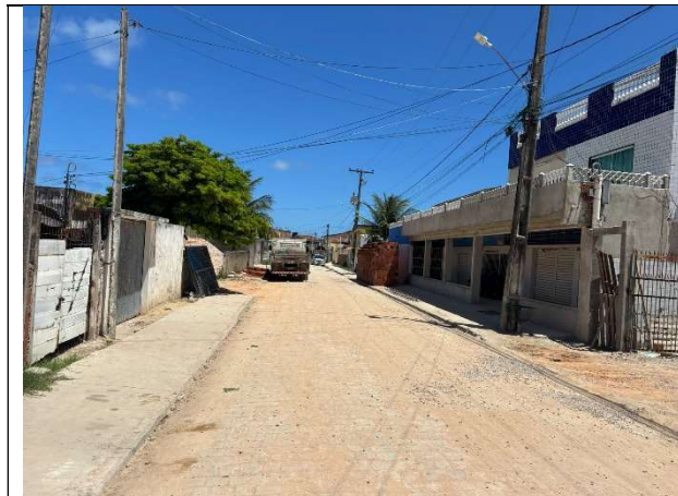
FOTO 1: Pavimentação e calçada executada;
