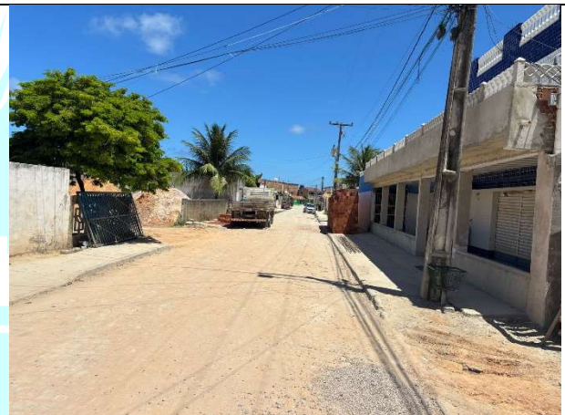
FOTO 2: Pavimentação e calçada executada;
