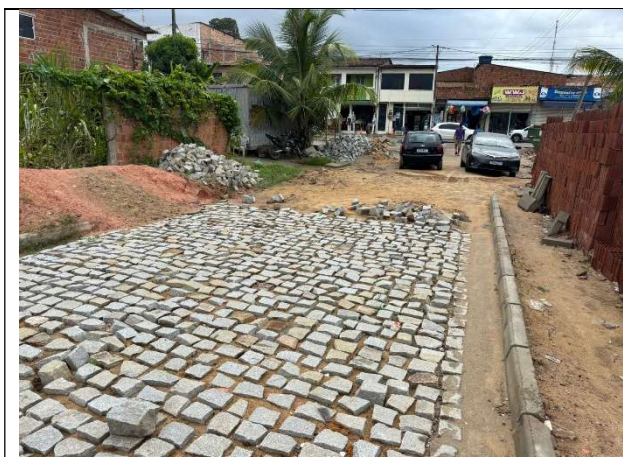
FOTO 1: Pavimentação em execução;
