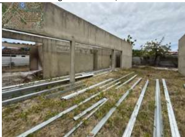
FOTO 3: Montagem da cobertura;
