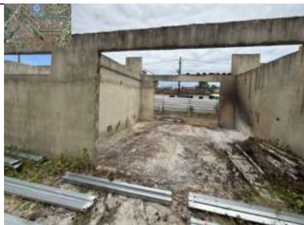
FOTO 2: Montagem da cobertura;
