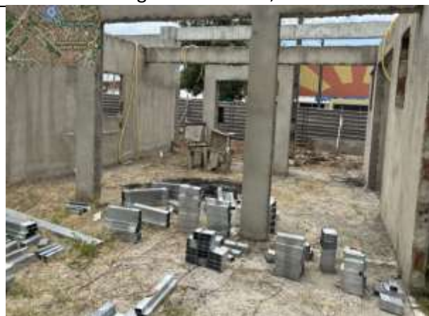
FOTO 4: Montagem da cobertura;
