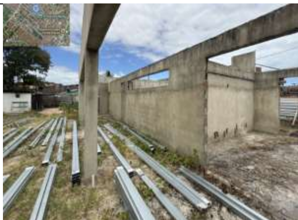
FOTO 1: Montagem da cobertura;
