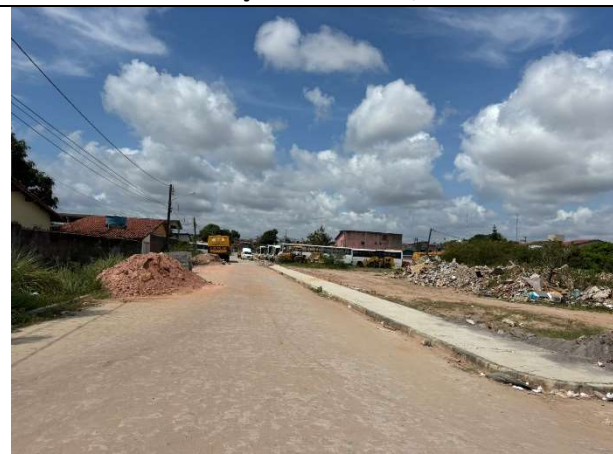
FOTO 5: Pavimentação e calçada executadas;
